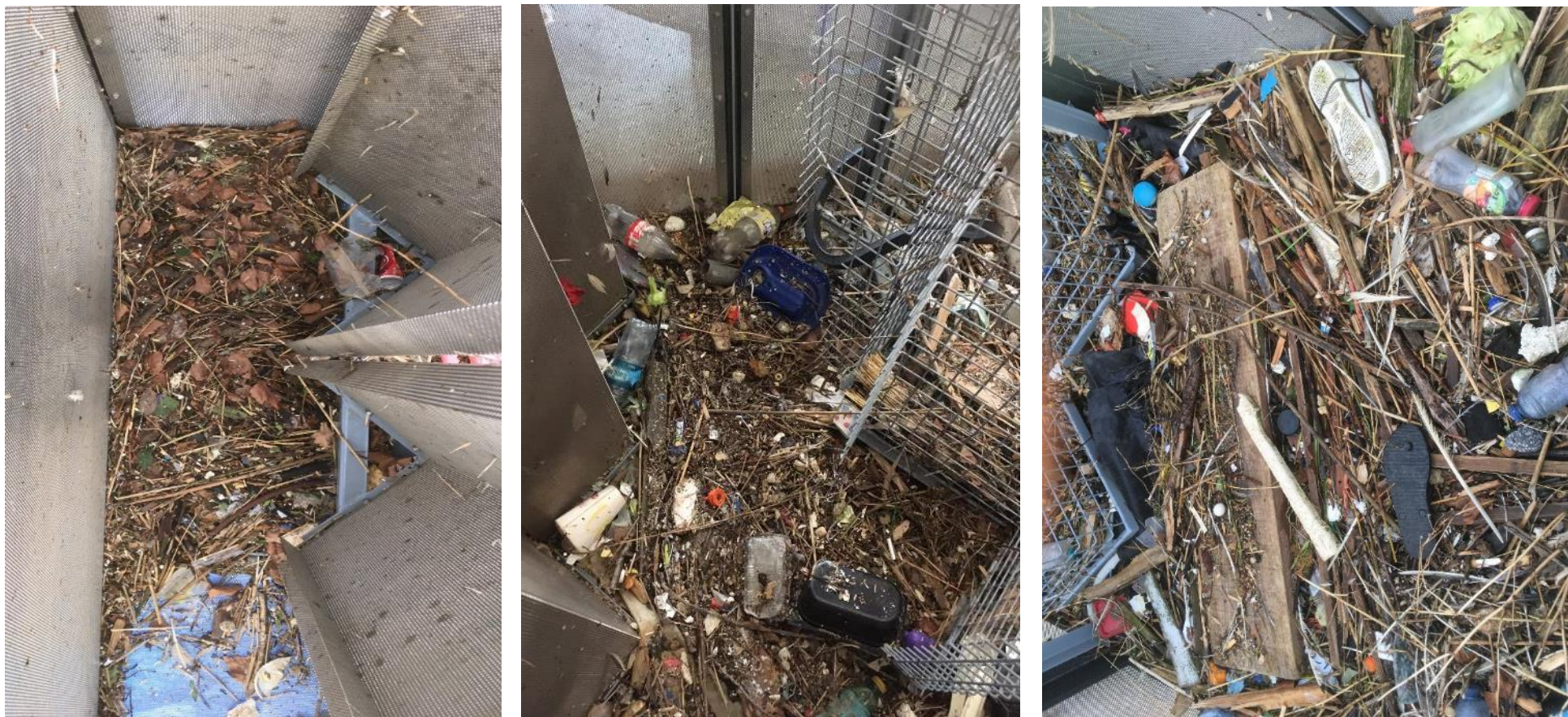
Figuur 4-4: Links: klein formaat vuil komt achter de micro-schotten en blijft daar vast hangen – Midden: groter formaat vuil komt achter de gaas schotten en blijft daar hangen – Rechts: het grootste formaat vuil blijft in de voorkant van de opvangbak liggen.
