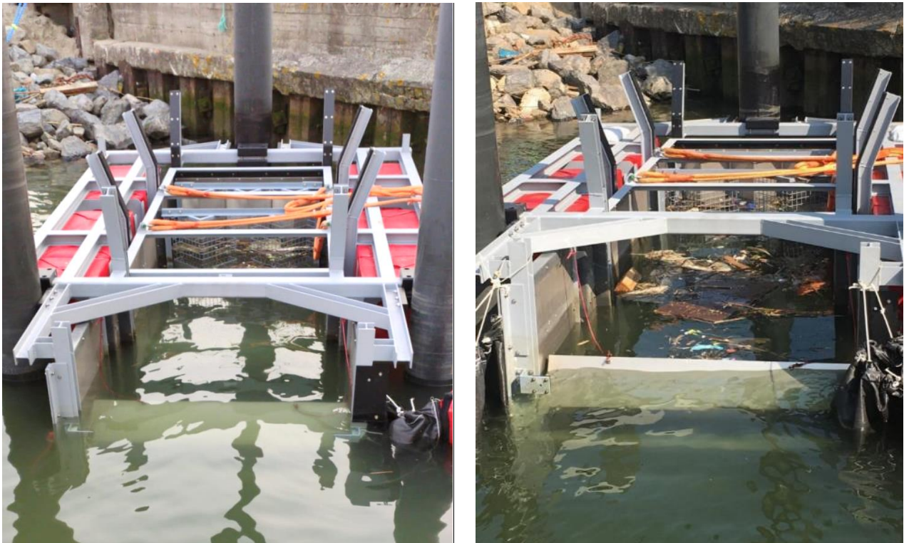
Figuur 4-3: Links: terugslagklep in open toestand bij voldoende wind en/of waterstroom uit het ZW – Rechts: terugslagklep in dicht toestand bij lage windsnelheden of wind en/of stroom uit tegengestelde richting.
