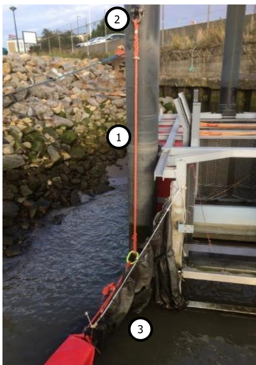
Figuur 3-4: Connectie tussen de 200 m afleider en de spudpaal via een verticale lijn (1) gespannen tussen twee ogen op de spudpaal (3) en connectie met het opvangsysteem via een uitbreidbaar scherm (3).
