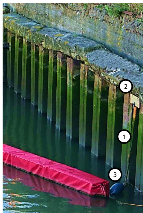
Figuur 3-5: Connectie tussen de 12 m afleider en de kademuur van Mammoet via een verticale lijn (1) gespannen tussen 2 metaal platen (2) gelast aan de kademuur. Fenders (3) zorgen ervoor dat de afleider de kademuur niet raakt.
