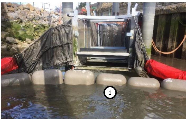
Figuur 3-10: Zes betonblokken (1) aan de voorkant van het systeem zorgen ervoor dat er geen afval onder het systeem geraakt bij zeer laag water.
